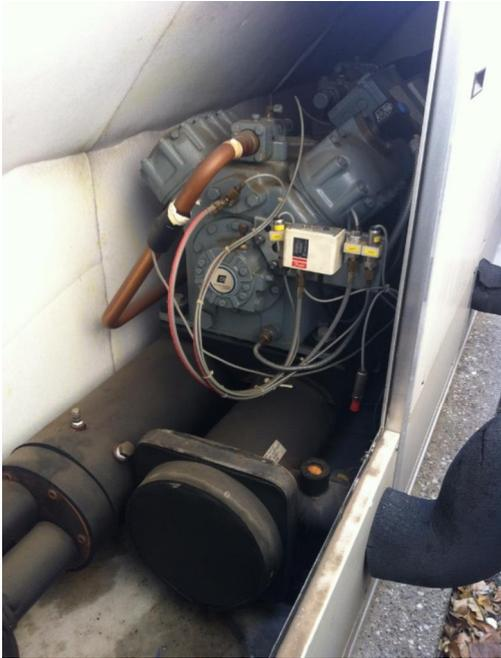
*Compresseur semi-hermétique avec les échangeurs*
